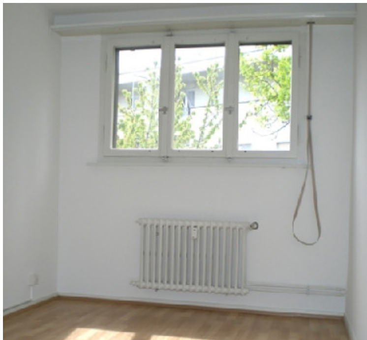
Zugband eines Rolladens. Wildensteinerstr. 23, 4052 Basel (1952)
